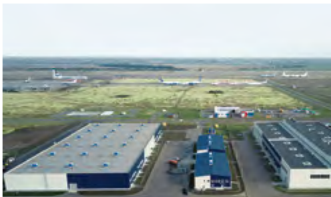
ПОЭЗ «Ульяновск–восточный» коллектор напорного трубопровода.
