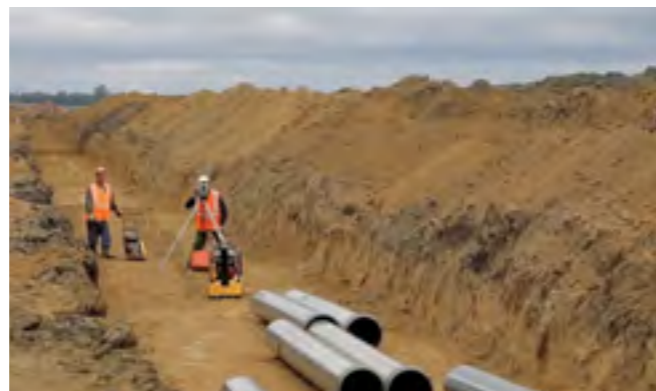
Монтаж напорного коллектора.
