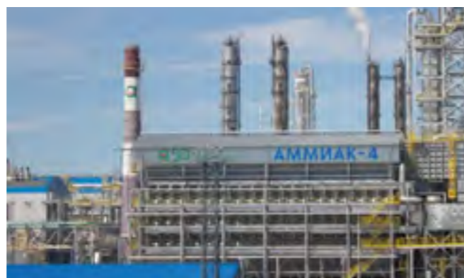
ПАО «Акрон», введены в эксплуатацию напорные трубы НПВХ ХЕМКОР, 400 диаметра.
